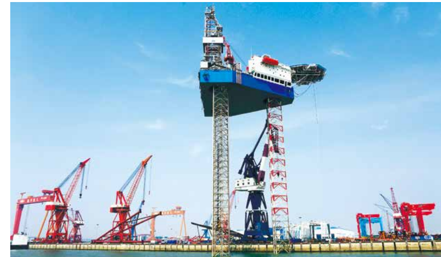
自升式钻井平台
