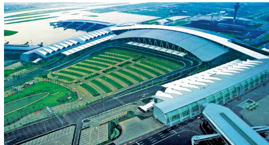
广州白云国际机场 Guangzhou Baiyun International Airport
