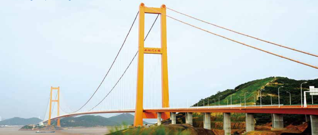
西堠门大桥 Xihoumen Bridge
