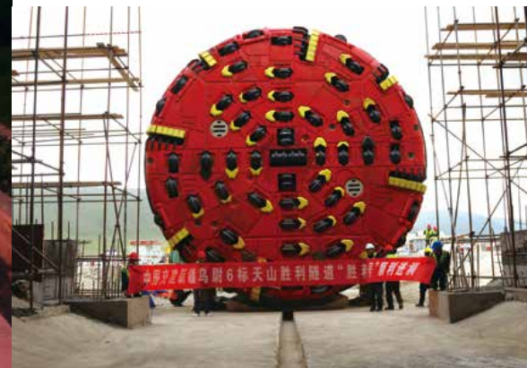
天山胜利隧道 Tianshan Shengli Tunnel
