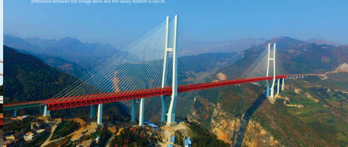
北盘江大桥 Beipanjiang Bridge
