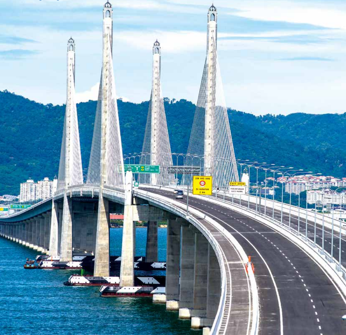
马来西亚槟城第二跨海大桥 Penang Second Bridge
