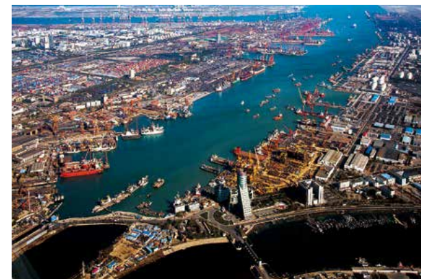
天津港 Tianjin Port
