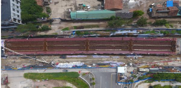
现浇箱梁混凝土为C50，砼采用泵送。为保证砼的质量，所有砂、石原材料在进场前进行过筛清洗；砼拌合站在施工前进行了期间核查，对计量秤进行了校核；试验室专人负责混凝土生产，严格按照配合比施工，严格控制进料顺序和搅拌时间，保证砼的坍落度和和易性。试验人员跟班作业，随时检查原材料的计量、砼的搅拌时间及各项指标，凡是不满足现场施工要求的不得进行砼浇筑，从源头杜绝影响现浇箱梁质量的不利因素。砼浇筑时采取同条件养生试件，为后期现浇箱梁预应力施工提供真实有效的数据。
