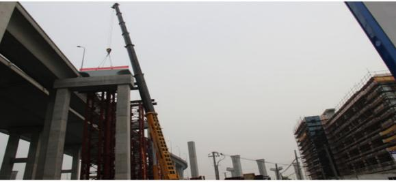
由中交二航局承建上海S26入城段新建工程7标在一片“噼里啪啦”的鞭炮声之后，随着起重师傅的口令下，由300吨“气势磅礴、体积庞大”的汽车吊车缓缓吊升空中，并安全的降落在安装好的支架上!标志着7标施工阶段由下部施工转为上部结构施工!
