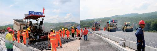
超前准备、最佳的机械组合和完善的后勤保障，顺利地完成了405米沥青下面层试验段摊铺。
