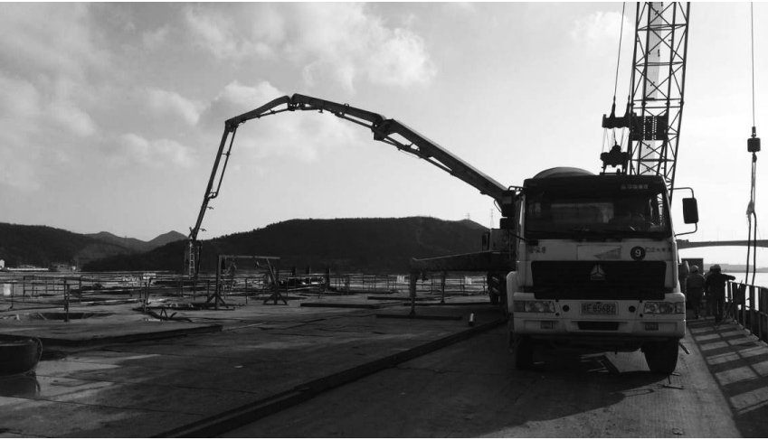
施工现场。龚创/摄
