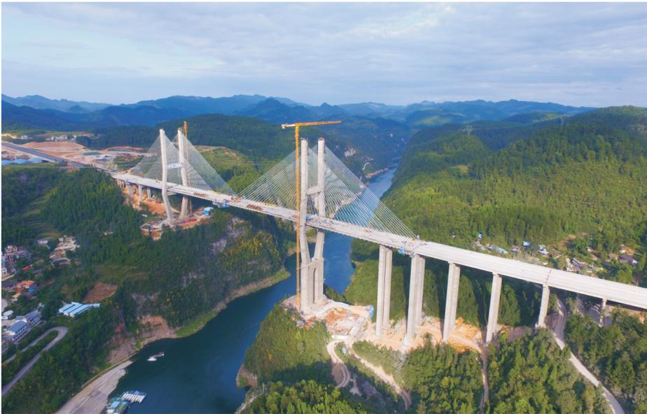
乌江大桥的建设全面转入主梁施工，2017年9月5日，乌江大桥4号墩主梁边跨现浇完成，9月19日，乌江大桥5号墩主梁边跨现浇完成，9月30日，乌江大桥中跨合龙。
