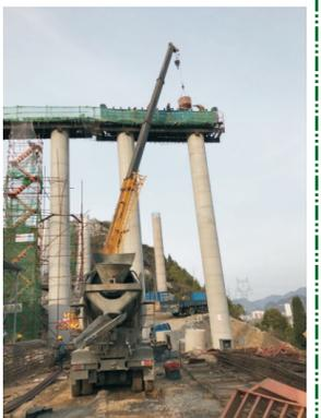
2月26日, 建恩高速五标二工区龙凤坝大桥左幅3#墩盖梁经过3个小时浇筑, 顺利完成, 成为建恩高速全线完成的第一幅盖梁。
