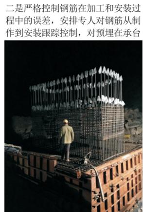
二是严格控制钢筋在加工和安装过程中的误差, 安排专人对钢筋从制作到安装跟踪控制, 对预埋在承台内的墩柱钢筋, 由测量人员反复复核, 确保钢筋位置的准确性。三是控制砼施工质量, 砼在拌和时严格按照配合比配料, 对砂、石含含水量试验, 严格控制施工配合比, 安排专人对所拌和的成品料进行出站前的初步检测, 砼采用砼运输车运输至现场, 运至现场的砼做坍落度试验。四是模板拆除后, 及时用手持电动砂轮将模板接头缝处的混凝土磨平, 确保混凝土表面光滑、美观。
