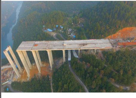
12月1日，乌江大桥最后一幅T梁架设完成，标志着乌江大桥全面转入主梁架设阶段。据悉，遵义至贵阳扩容工程4-A合同段共有T梁126幅，其中30米T梁48幅，42米T梁42幅，40米T梁14幅，42米T梁70幅。目前，乌江大桥4号索塔5号墩已浇筑完成，预计2017年11月全桥合龙。(赵凯)
