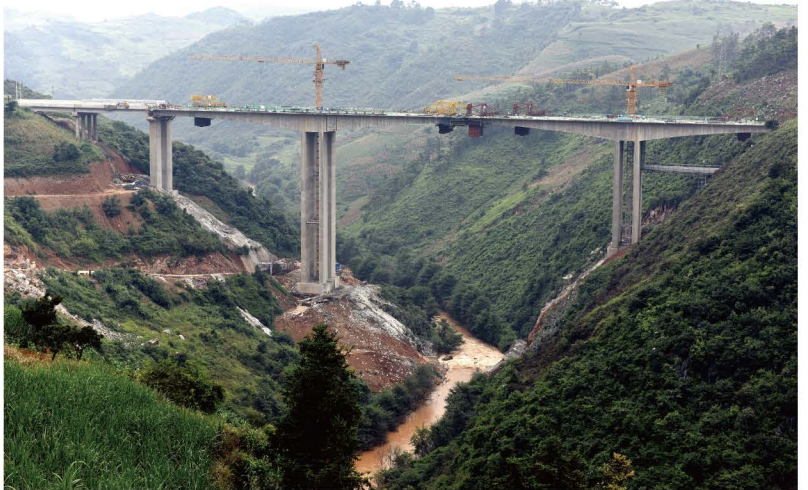
建设中的盘龙三号大桥
