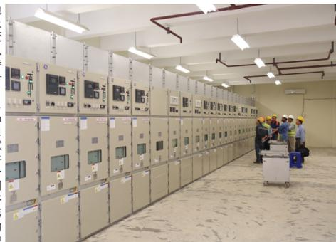
本次主要是对业主运营区内1#变电站到码头吊桥区域的电源线路进行11kV高压供电测试，该高压供电是集装箱码头试运营的基本条件，测试结果将直接影响到项目的后续施工。11kV高压一次性送电成功，标志着整个项目的电气工程已经迈过了至关重要的一关，项目部下一阶段还将进行1#变电站到3#、27#变电站的高压供电测试以及变电站到房建、路灯、高杆灯和CCTV监控的低压供电测试。
