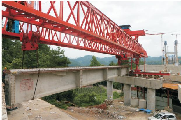
7月6日，乌江大桥银盆分离式立交第一榀T梁架设完成，乌江大桥引桥下构施工也全部完成，标志着乌江大桥引桥已全面进入上构施工。
