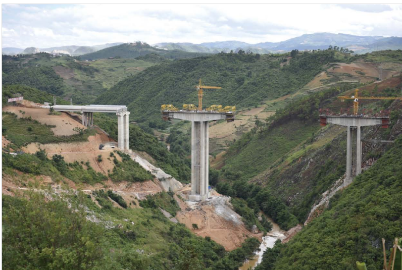
建设中的盘龙三号大桥
