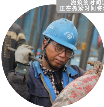
浇筑的时间近了，工人正在抓紧时间将地泵敲紧。
