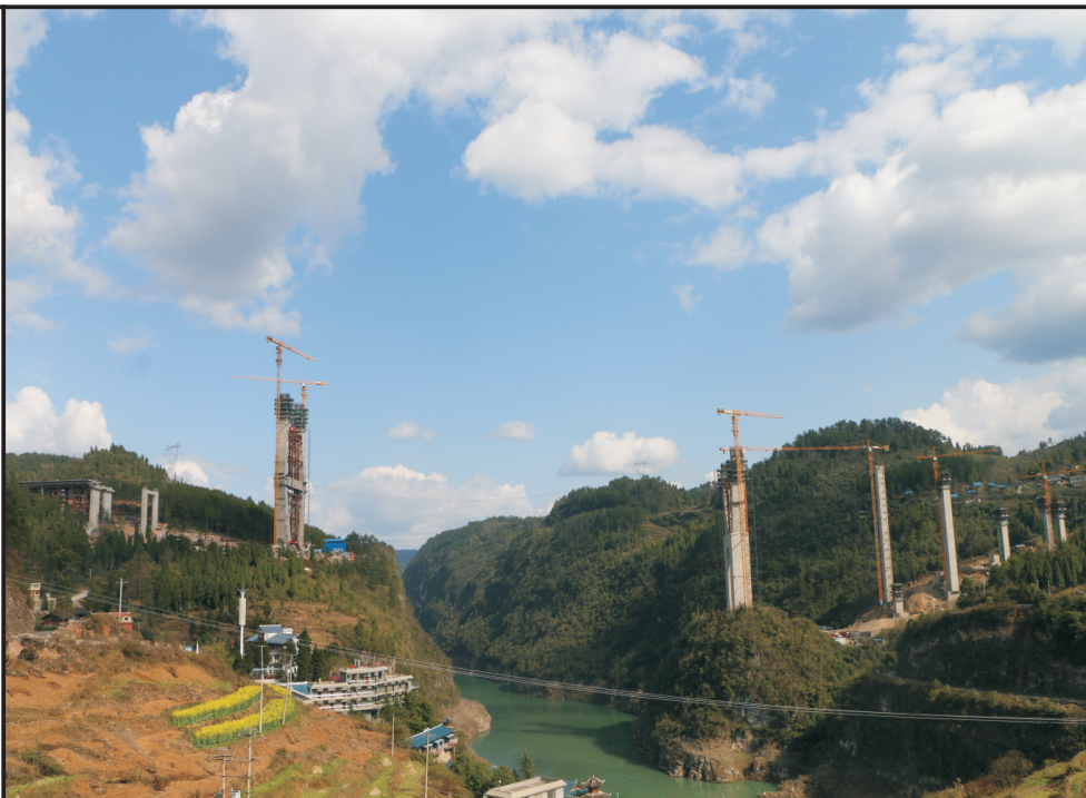
图为：乌江大桥全景
