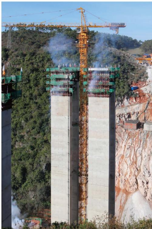
盘龙河3号大桥全长346米,宽24.5米,孔跨布置为30+(65+120+65)+2×30m。其中主桥采用变截面预应力混凝土连续刚构箱梁,两岸引桥均采用预应力混凝土T梁,蒙自岸为一跨简支,砚山岸为两跨先简支后桥面连续。大桥3#主墩为双肢实心薄壁墩,墩高59米,尺寸为6.5×1.8m。采用翻模法施工,于2015年10月6日浇筑首件墩身,12月23日实现顺利封顶。3#主墩的封顶标志着蒙文砚高速项目部向盘龙河3号大桥上构施工迈出了至关重要的一步。
