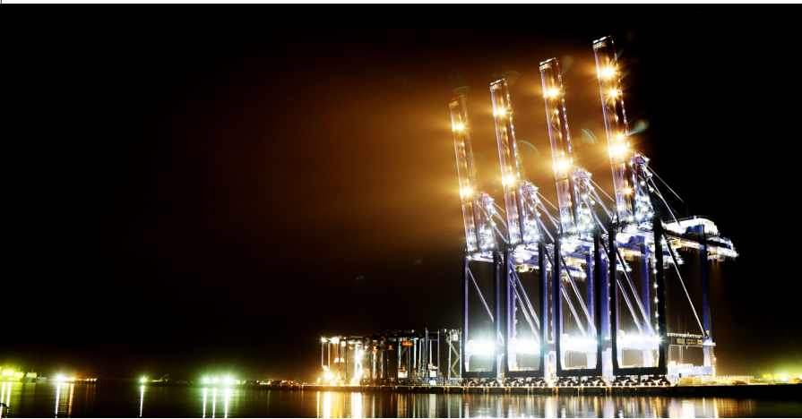
项目夜景：图为正在建设中的巴基斯坦卡拉奇深水港码头项目
