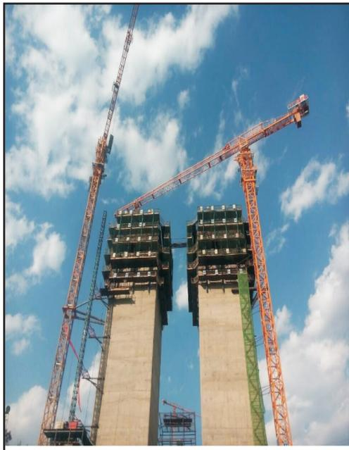
图为：乌江大桥主5号墩（乌江大桥主5号墩位于贵阳岸，高197.1米，现已进入下塔柱施工阶段）。
