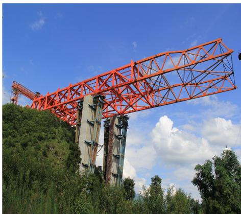
由二航局五分公司承建的毕都高速 T17 标项目北盘江特大桥进入上构施工期，现在正进行的是钢桁梁的拼装顶推施工。北盘江特大桥是毕都高速线的控制性工程，是目前世界最大跨径的钢桁梁斜拉桥。作为世界级桥梁，技术安全等指标要求都比较高。项目自进场以来就保持“严要求、高标准”的状态进行施工。通过项目全体员工努力，现在已完成拼装顶推施工 160 米。 (谢刚)
