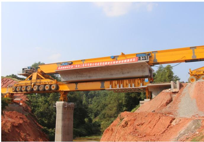
(本报讯 通讯员 夏发志) 7月8日20:26分,随着900T运架一体机将重569.9吨,长24m的箱梁平稳准确无误地放置在成贵铁路大田边中桥1#墩-2#墩桥台之间,中交二航局成贵铁路4标成功架设成贵铁路全线首榀箱梁。
