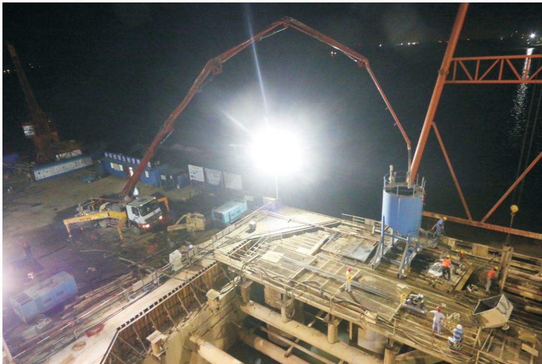
图为深夜,沌口大桥4号墩最后根桩浇筑中。(张天文、综合办摄影)
