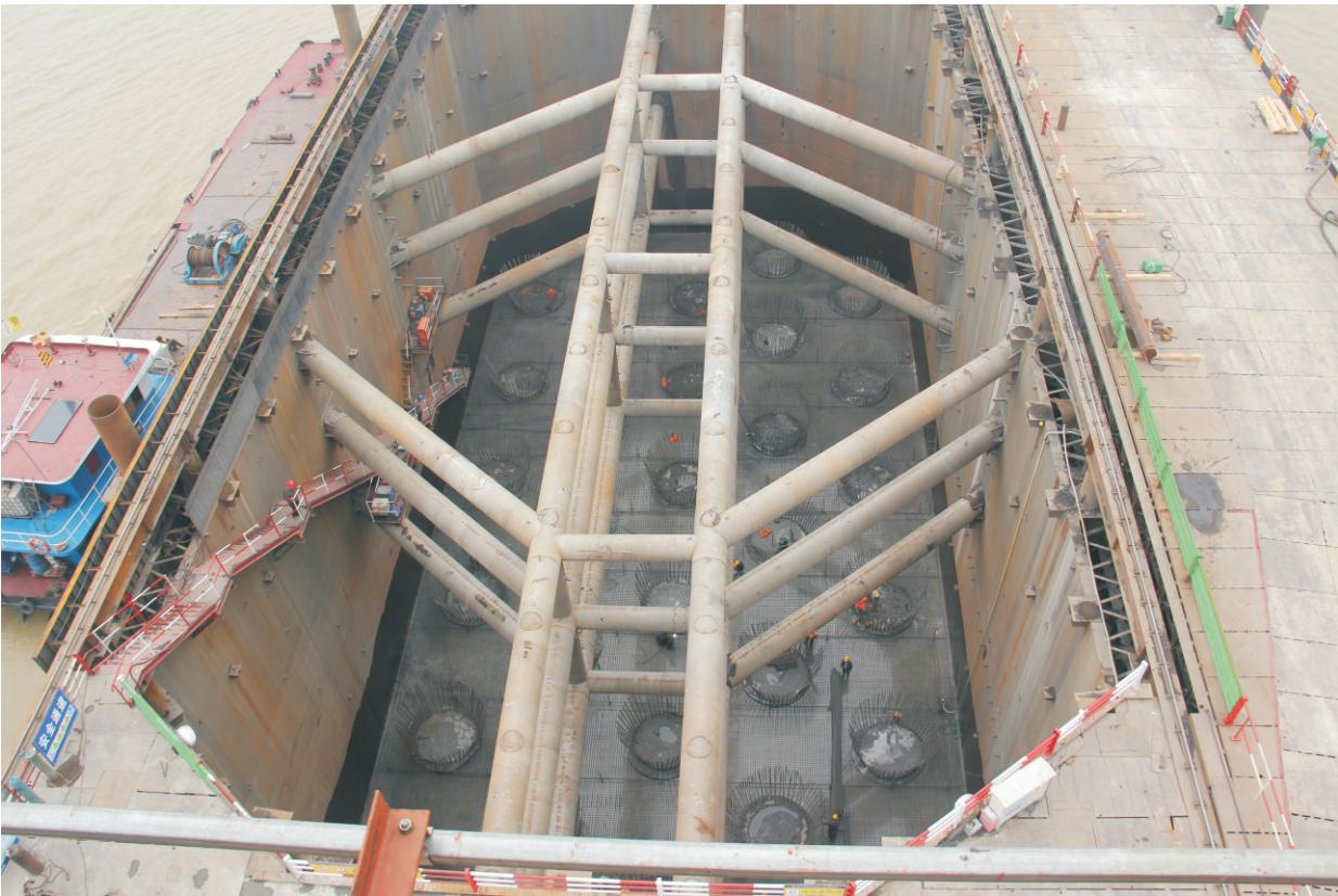
图为沌口大桥3号主墩正在进行钢筋绑扎。(刘福星摄影)
