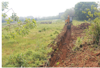
图为南接线分部大桥主线红线沟开挖。
