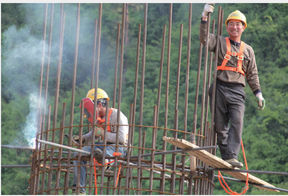
现场工人特写——桩基钢筋笼焊接
