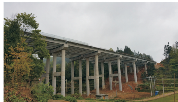
▲图为鄯家湾大桥施工现场
