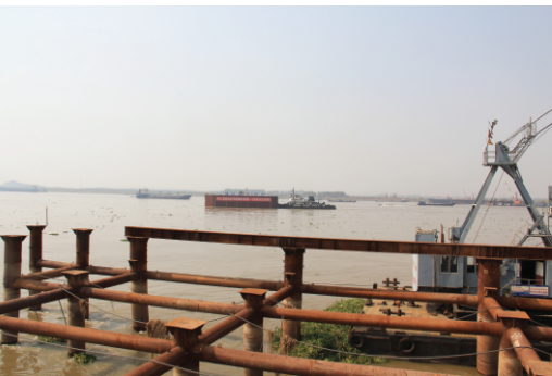
钢围堰浮运中
