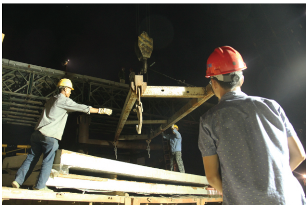
为了让南岸施工主便道早日贯通，施工人员连夜加班铺桥面版。
