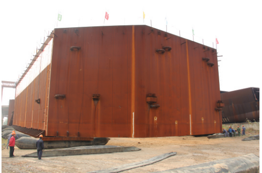
钢围堰采用气囊支垫
