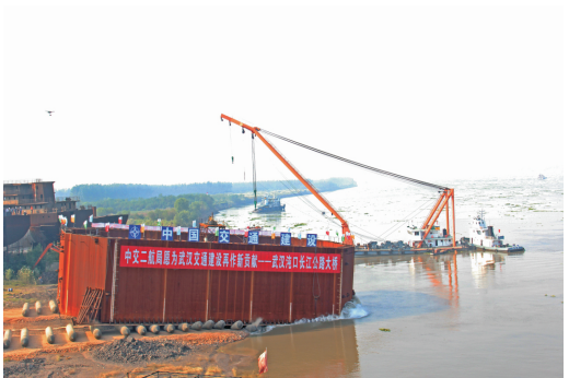
钢围堰顺利下水
