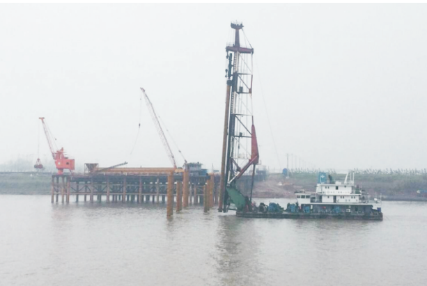
图为2#~3#钢栈桥打桩施工中
