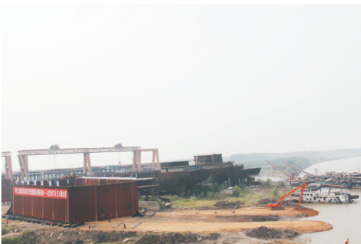
进一步修整下水坡道,准备钢围堰滑移至江边
