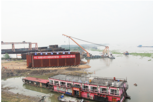
钢围堰滑移至江边,准备下水
