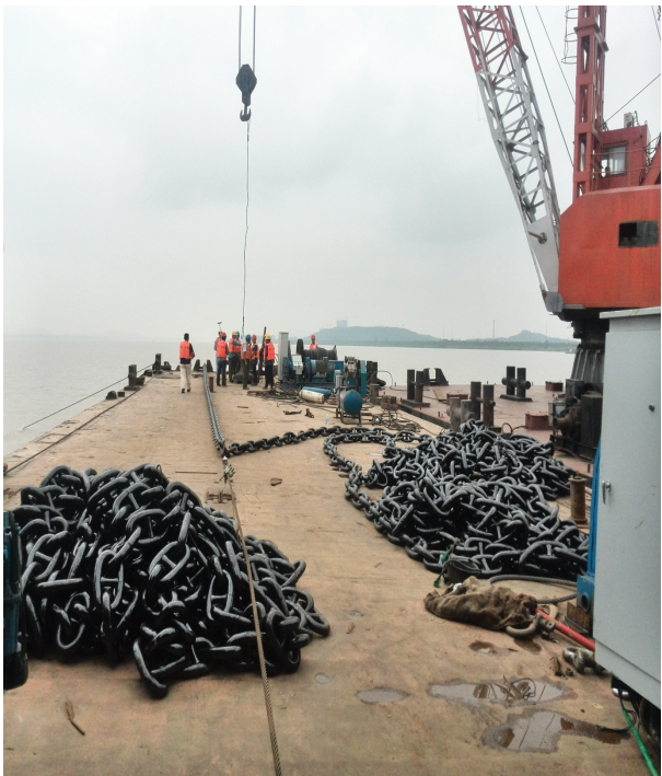
图为北岸钢围堰定位系统抛锚中
