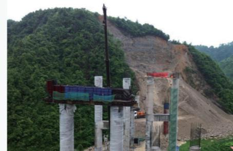
银沟1#大桥左幅1#墩盖梁，长度10.8m，高度
