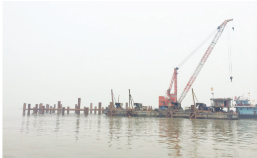
图为4#墩(南岸分部主墩)施工平台。
