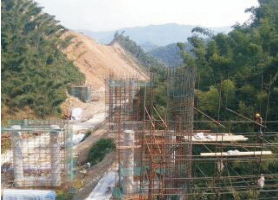
上图为九房湾大桥施工现场
