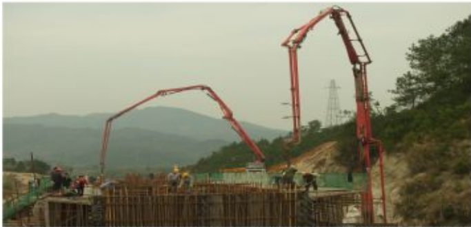
本报讯 中交二航局大岳高速于4月1日首次浇筑最大一次混凝土方量的箱梁，物资部克服料场小、水泥罐存储少等困难，积极于各方沟通，配合项目部顺利完成了箱梁的浇筑任务。
