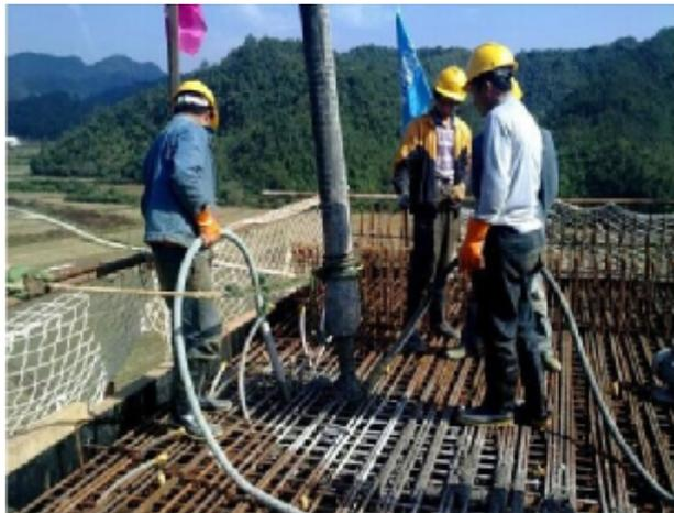
同时，项目部制定连续梁混凝土浇筑施工保障专项方案，成立了混凝土浇筑领导小组，并按技术、物资设备、安全质量、施工协调、混凝土供应等不同分工实行循环现场值班制度，以保证混凝土浇筑过程的连续性及安全质量稳定可控。施工中，全体参建人员在分部经理的统一指挥下，团结协作，奋力攻坚，历时7个小时顺利完成1#块砼浇筑任务。（徐尧 周伟其）
