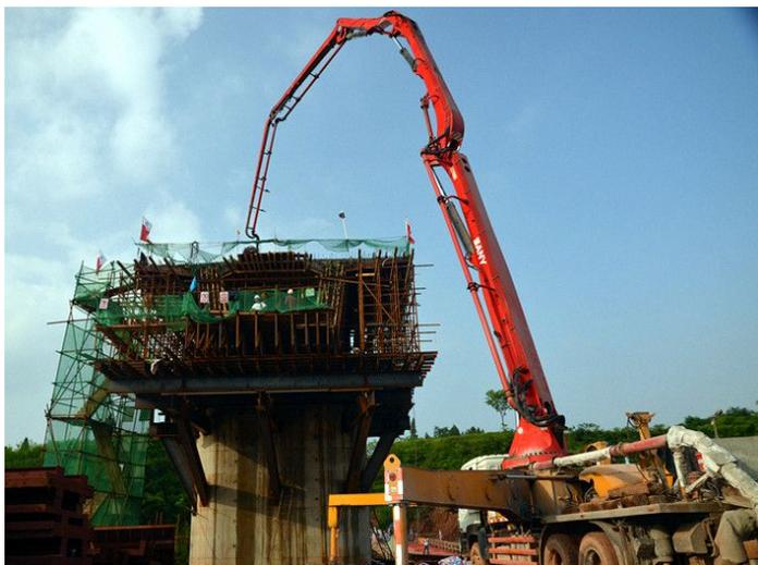
栗家湾双线特大桥连续梁位于重庆市垫江县曹回镇境内，连续梁起讫里程为DK142+912.05 ~ DK143+049.75，全长136.2m，为渝万铁路项目重点控制性工程之一。连续梁结构形式为（40+56+40）m变截面预应力混凝土连续箱梁，主墩
