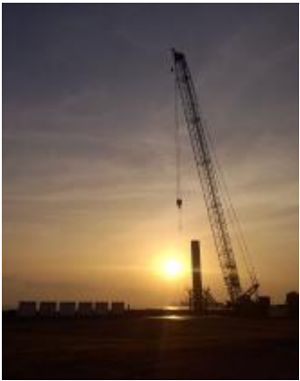
朝阳下,即将打入的中委第一桩 (龙光旭)
