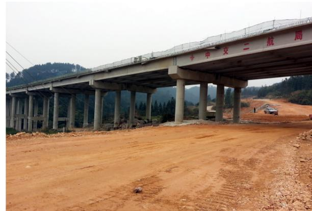
12月31日，项目控制性工程鹅田坝大桥贯通。该桥长366米，为先简支后连续的30米T梁。大桥的贯通，为明年上半年交工验收奠定了坚实的基础。
