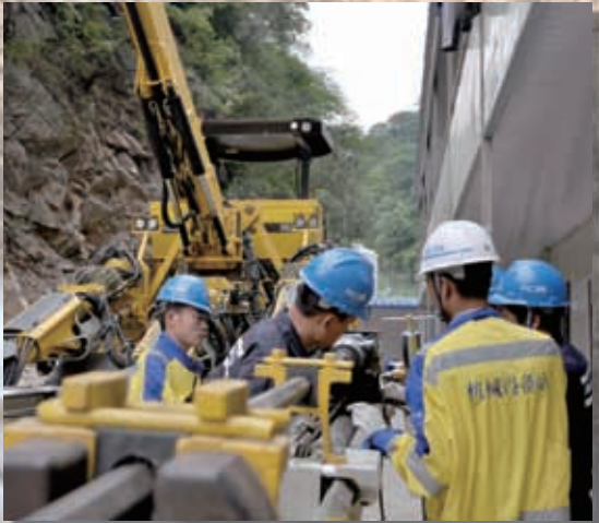
三臂凿岩台车检修保养
