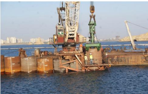
统连锁管桩定位形式，发明创新可快速定位连排式锁扣钢护筒的骑跨式液压支座定位导向架，极大的提高了胸墙桩基护筒的施工效率，并成功申请专利。本着在实践中不断总结经验，在总结中不断改良工艺，在改良中不断提高质量的精神，码头胸墙桩基钢护筒沉设施工成功克服了桩基数量多、直径大，地质层复杂多变、岩层强度高，海床几乎无覆盖层及海上施工等诸多难题提前完成生产任务。
