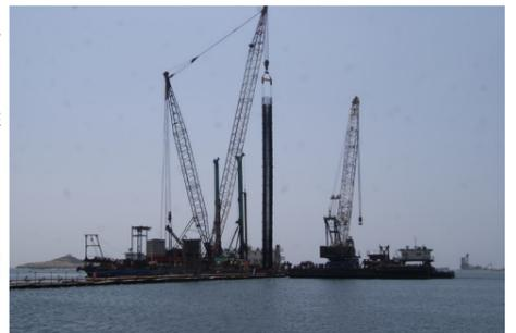
卡拉奇每年7月至9月的西南季风持续影响了整个3号泊位的前排桩桩基施工生产，在季风期施工期间，海上施工方驳的稳定性受到了较大的挑战，导致水上旋挖钻孔以及钢筋笼水上吊装施工均受到一定程度的影响。项目部针对前排桩季风期间的施工，经过多次会议讨论，认真研究并制定了一系列施工保证措施，如合理选取各个工序的作业时段，通过调节压舱水和增加抗扭锚提高海上施工方驳的稳定性等举措，确保了码头3#泊位前排桩桩基在季风期间的施工进度。
