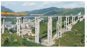
140 吨 梁, 稳稳安放在大桥左幅 0 号标台和 1 号标 墩上。至此,杨柳湾大桥左幅 70 片 9 米 T 梁 部架 设完成,向实现本合同段左幅贯通目标又迈出了 坚实的一步。
