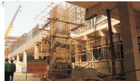
PM 31墩身钢筋绑扎
