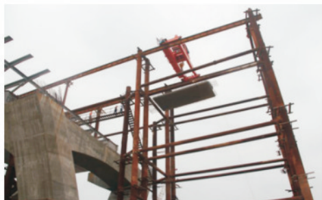
河东提板桁吊吊装桥面板
