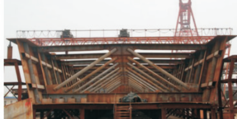
河西水中引桥钢槽梁拼装
