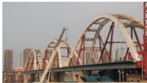
主桥三跨钢拱梁整体顶推
