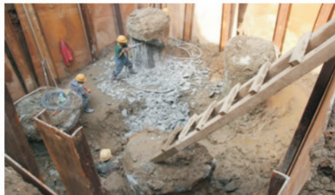
PM 32墩承台破桩头
