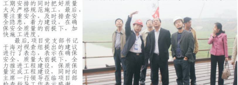
项目书记于海在施工现场向长沙市政协副主席(中)介绍大桥施工情况
