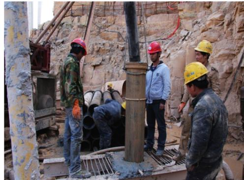
8号主塔15号桩施工现场灌注过程。
