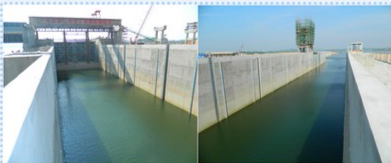
船闸过水图片
