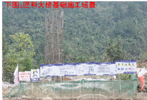
下图:匠科大桥基础施工现场
