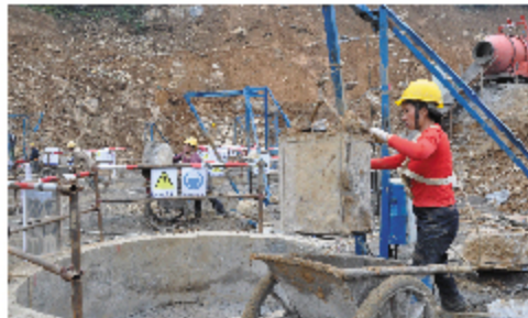
上图:忠建河大桥热火朝天的施工场景
