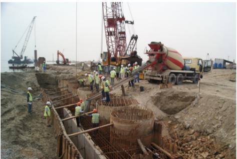
后进行。胸墙的总长度为1712.88m，其中包括南端转弯段54.5m，胸墙高度为6m，宽度5.15m~6.25m，最小悬臂2.4m，最大悬臂3.45m。胸墙外侧为预制面板，与胸墙通过现浇混凝土连接成为整体，混凝土强度等级为C40，底标高为-1.0m，顶标高为5m。结合胸墙结构特点，经过全面的分析和施工方法的对比，决定胸墙施工采用分三次浇注混凝土的方法进行。即下部预制板安装后进行封底，第一次混凝土浇筑到桩顶标高，安装上部预制板，第二次混凝土浇筑到+3.50m，第三次混凝土施工到胸墙顶部。
