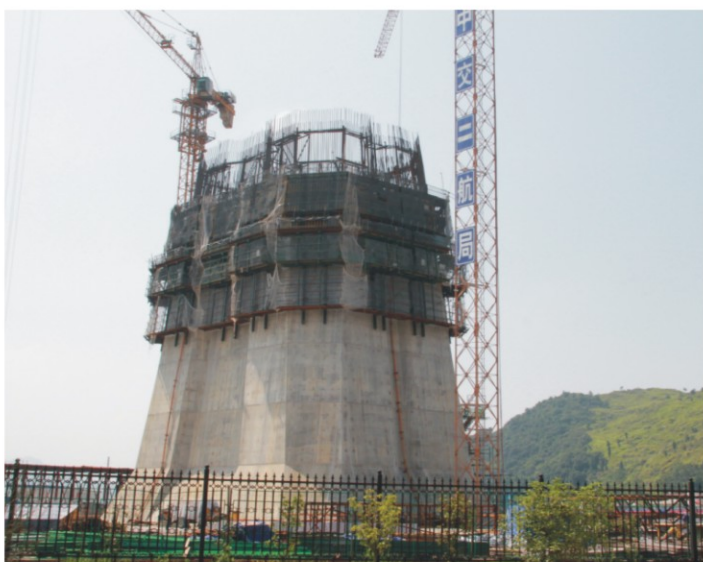
图为施工中的赤石特大桥7#主墩
