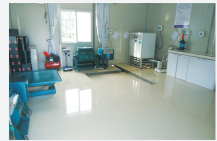
标准化混凝土室
