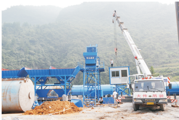
建设中的标准化搅拌站
