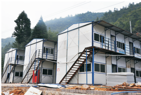
建设中的标准化办公区
