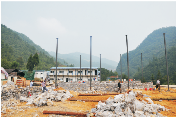
建设中的砂石料堆放厂
