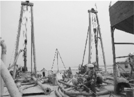
图1:8#墩水上平台桩基施工现场。
