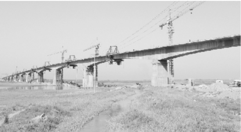
图2:大城西黄河大桥11对挂篮如展翅的群雁,已经呈现出一道美丽的弧。
