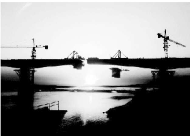
长河落日——大城西施工过程中呈现出的美景
