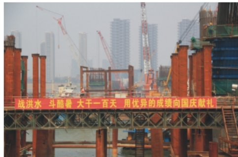
劳动竞赛施工现场
