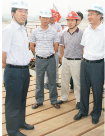
长沙市委书记陈润儿(左一)、长沙市委副书记李军(右一)莅临施工现场检查指导工作
