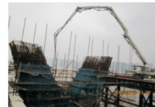
PM19-2第三节墩身施工
