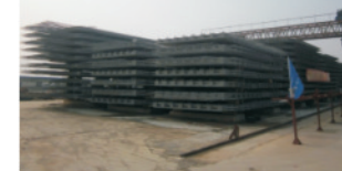
已预制完成的桥面板
