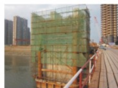
PM27最后一节墩身施工
