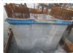
PM21-1两节墩身浇筑完成
