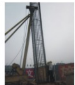
PMX03-2桩基浇筑
