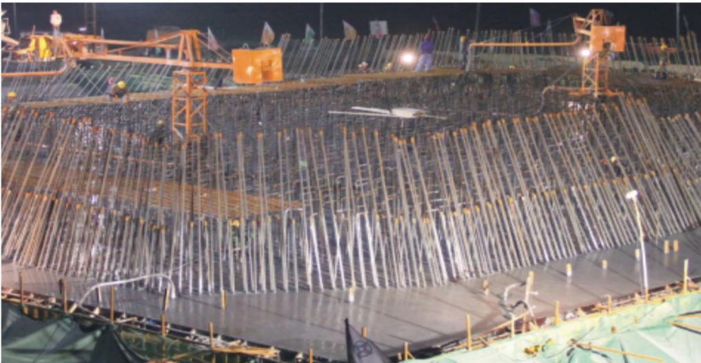
图为七号墩施工现场
